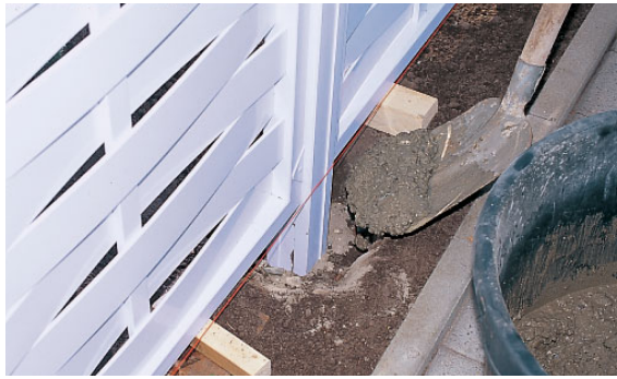
Zaunpfosten direkt ins Erdreich einbetonieren...
