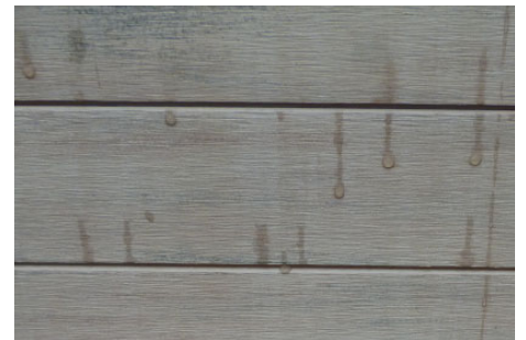
Fleckenbildung durch von Regen angelöste Partikel
