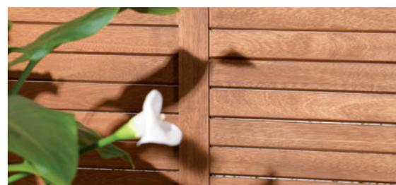
Die an der Unterseite leicht angeschrägten Lamellen erlauben - je nach Blickwinkel - eine leichte Durchsicht.
